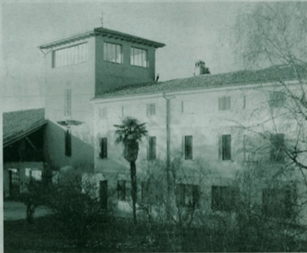
La cascina all'interno della quale è inserito il centro di ricerca veterinario che opera a Romanengo e che si sta distinguendo per le sue attività e le attrezzature di cui dispone.
